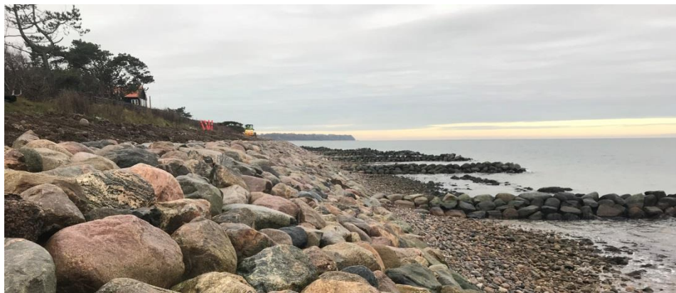
Figur 3.26: Beskyttet kyst med skråningsbeskyttelser og hølfer ved Villingebæk (St. 42,2-43,2).
