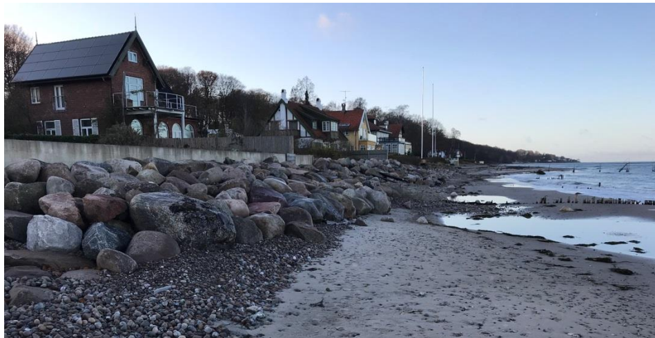
Figur 3.32: Højstrup Strand præget af usammenhængende skråningsbeskyttelser (St. 55,2-57,2).
