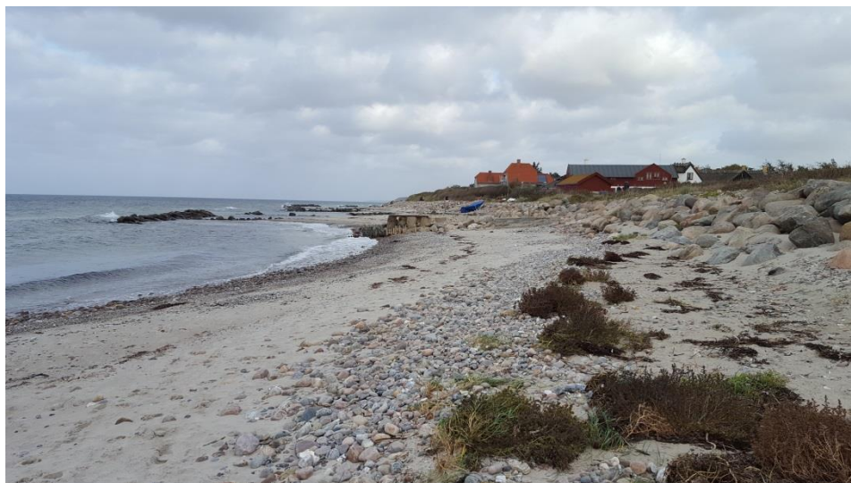
Figur 3.12: Kikhavn beskyttet med bølgebrydere og skråningsbeskyttelse (St. 1,9-3,3).
