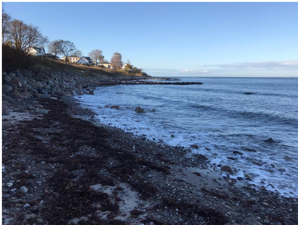
Figur 3.31: Kyststrækning præget af skråningsbeskyttelser og høfder ved Hellebæk (St. 53,2-54,2).
