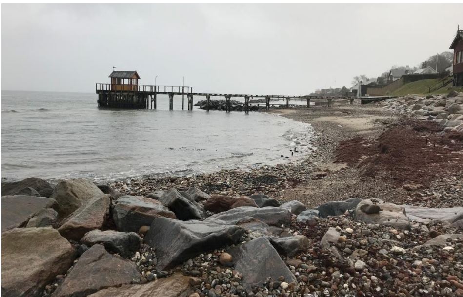
Figur 3.29: Kyststrækning ved Ålsgårde beskyttet med skråningsbeskyttelse, bølgebrydere og høfder (St. 49,5-50,5).
