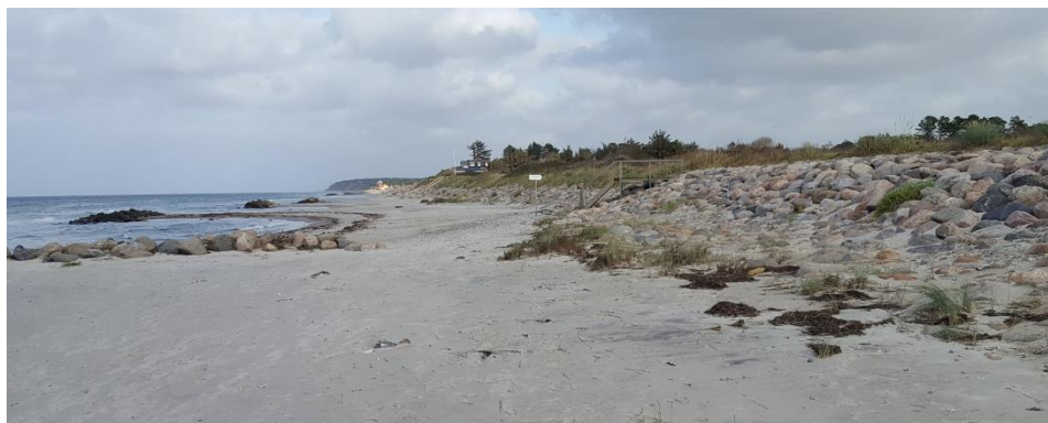
Figur 3.13: Lavtliggende bagland beskyttet med skråningsbeskyttelse og bølgebrydere ved Galgebjerg (St. 3,3-4,4).
