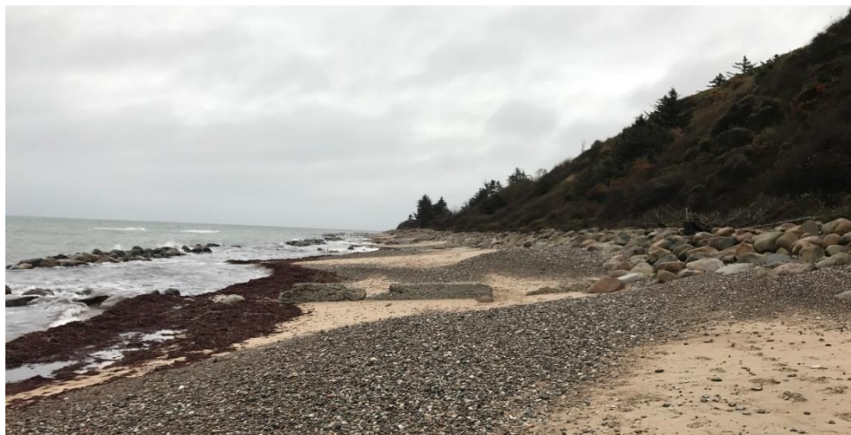
Figur 3.22: Gilleleje Strand beskyttet med skråningsbeskyttelse og bølgebrydere (St. 33,0-35,2).
