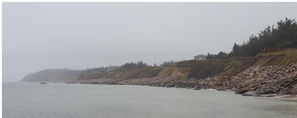
Figur 3.14: Aktiv skrænterosion over skråningsbeskyttelse ved Hald Strand (St. 4,4-6,8).
