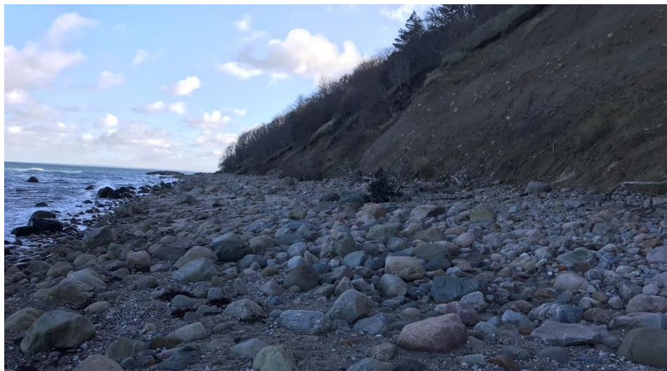
Figur 3.23: Generelt ubeskyttet kyststrækning med aktiv skrænterosion ved Nakkehoved. I baggrunden ses bølgebryder udført i betonelementer ved Nakkehoved Fyr (St. 37,4-39,6).
