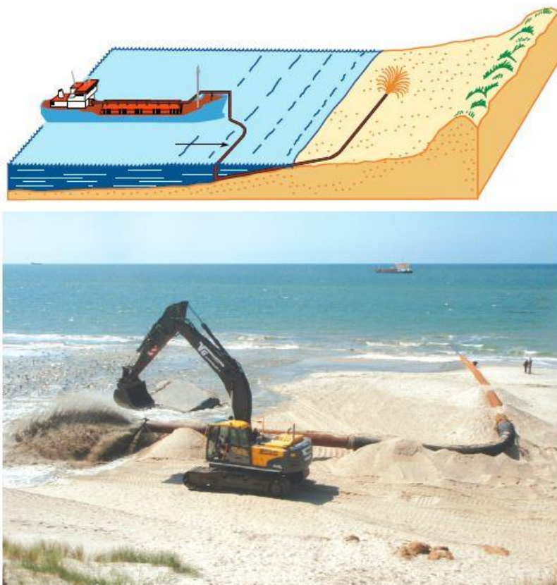
Figur 8.1 Strandfodring med indvindingsfartøj tilkøbet rørledning, der pumper sand og ral ind på stranden til videre fordeling, KDI.
