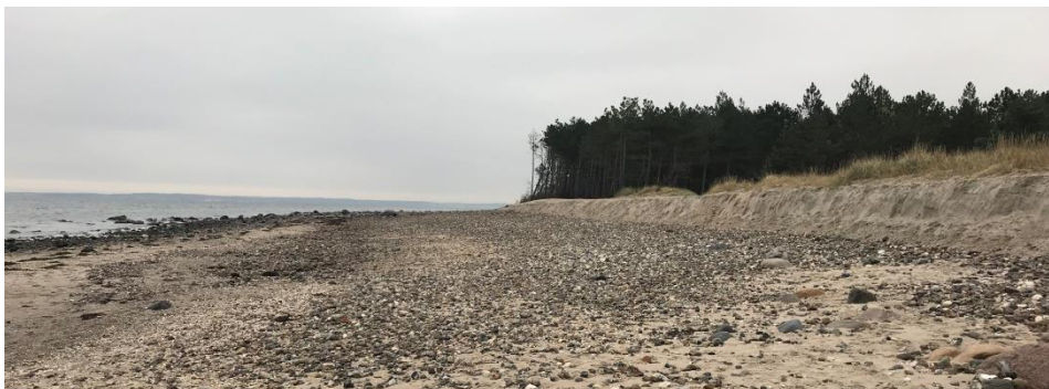
Figur 3.28: Ubeskyttet erosionskyst i den vestlige del af Hornbæk Plantage (St. 46,1-48,6). Bemærk erosionskant i strandfodringsmateriale efter stormen Ingolf 28.10.2017.
