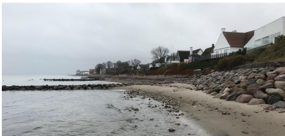
Figur 3.30: Kystbeskyttelse i form af høfder og skråningsbeskyttelser ved Ålsgårde (St. 50,5-53,2).
