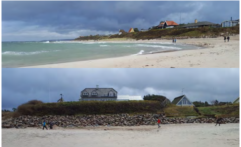
Figur 1.12: Bølgebrydere og varierende skråningsbeskyttelse langs Liseleje (St. 7,7-9,5).
