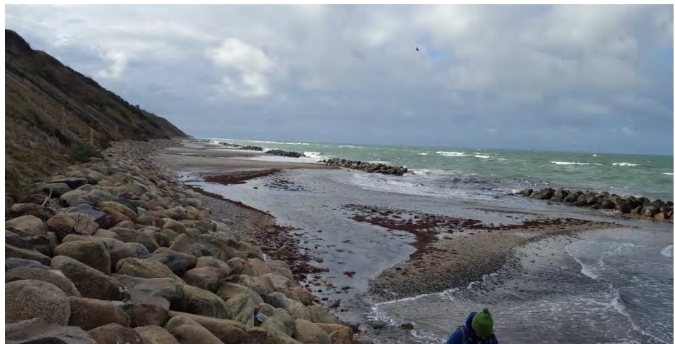
Figur 1.16: Kyststrækning med skråningsbeskyttelse og erosion bag bølgebrydere, fra Tisvildeleje-Vejby Strand (St. 17,4-22,8).
