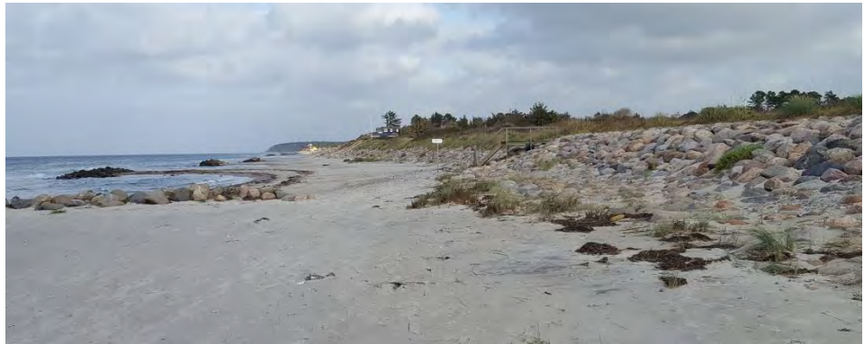
Figur 1.9: Lavtliggende bagland beskyttet af med skråningsbeskyttelse og bølgebrydere ved Galgebjerg (St. 3,3-4,4).
