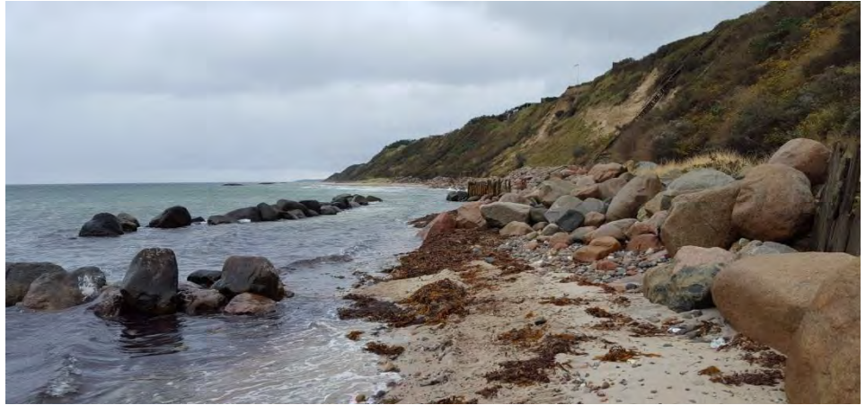
Figur 1.11: Skræntbeskyttelse ved Hyllingebjerg (St. 6,8-7,7).
