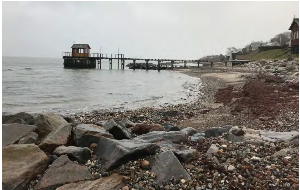
Figur 1.37: Kyststrækning ved Ålsgårde beskyttet med skråningsbeskyttelse, bølgebrydere og høfder (St. 49,5-50,5).
