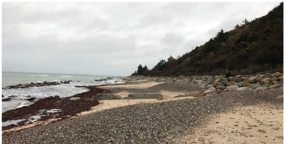
Figur 1.24: Gilleleje Strand beskyttet med skråningsbeskyttelse og bølgebrydere (St. 33,0-35,2).
