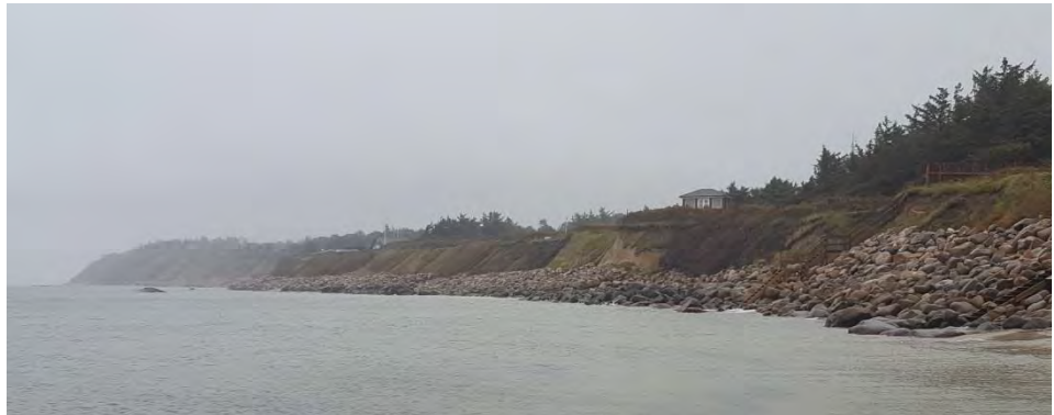
Figur 1.10: Aktiv skrænterosion over skråningsbeskyttelse ved Hald Strand (St. 4,4-6,8).
