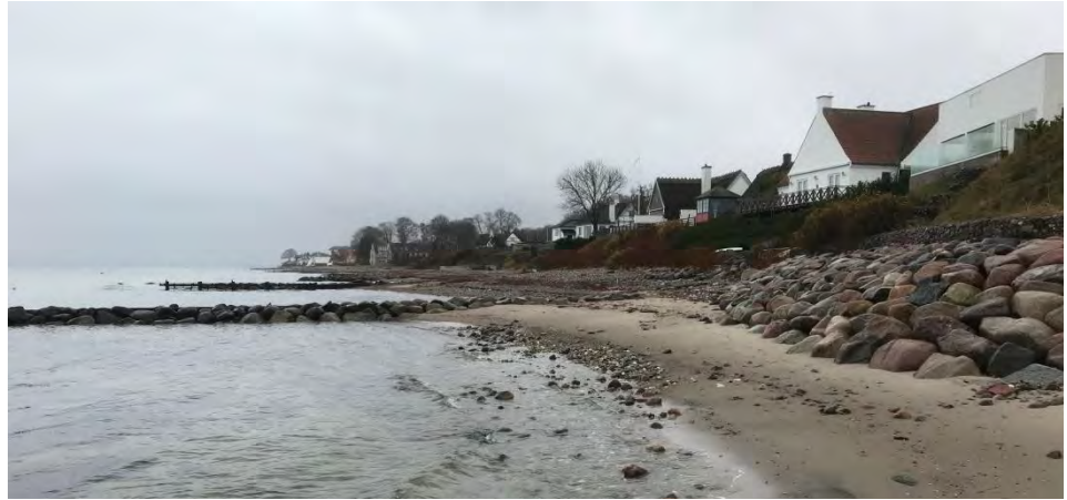
Figur 1.40: Kystbeskyttelse i form af hofder og spredt skråningsbeskyttelse ved Alsgårde (St. 50,5-53,2).
