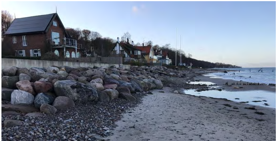
Figur 1.45: Højstrup Strand præget af delvist usammenhængende skrånings- og stormflodsbeskyttelse (St. 55,2-57,2).
