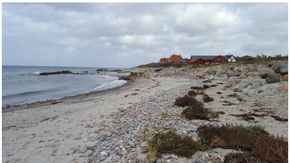
Figur 1.6: Kikhavn beskyttet med bølgebrydere og skråningsbeskyttelse (St. 1,9-3,3).
