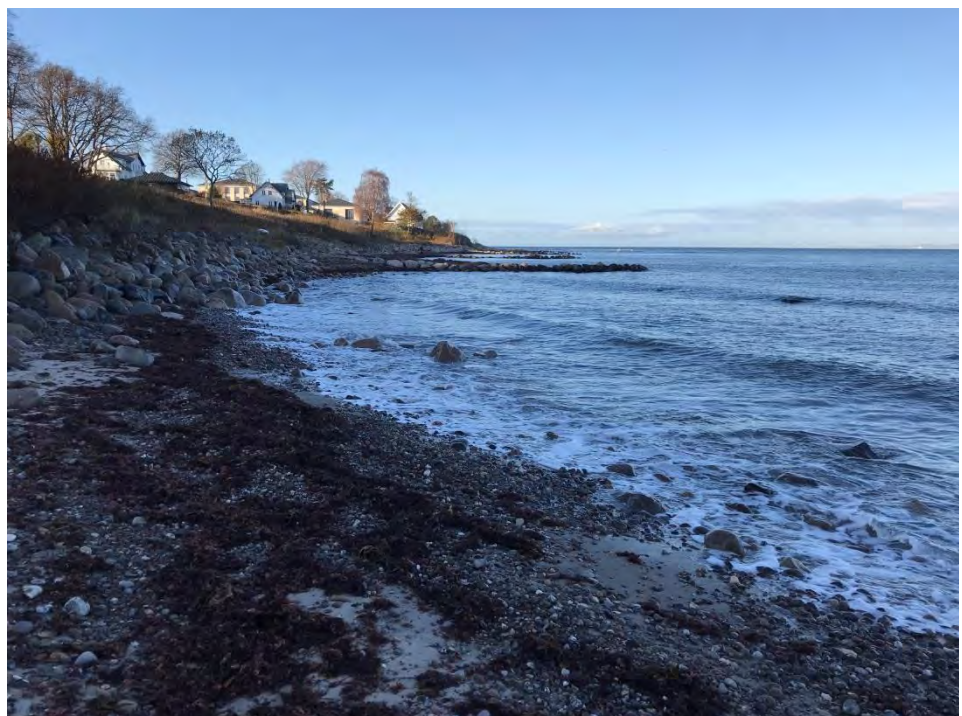
Figur 1.43: Kyststrækning præget af skråningsbeskyttelse og hælfer ved Hellebæk (St. 53,2-54,2).
