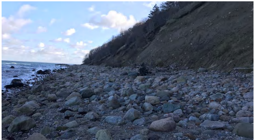
Figur 1.28: Generelt ubeskyttet kyststrækning med aktiv skrænterosion langs Nakkehoved. I baggrunden ses bølgebryder ved Nakkehoved Fyr (St. 37,4-39,6).
