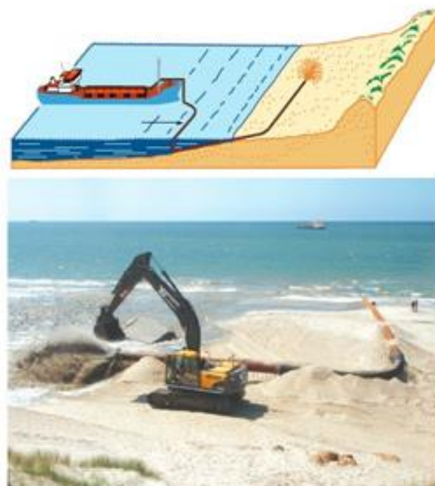
Figur 2-15 Indpumpning og fordeling af sand på stranden
