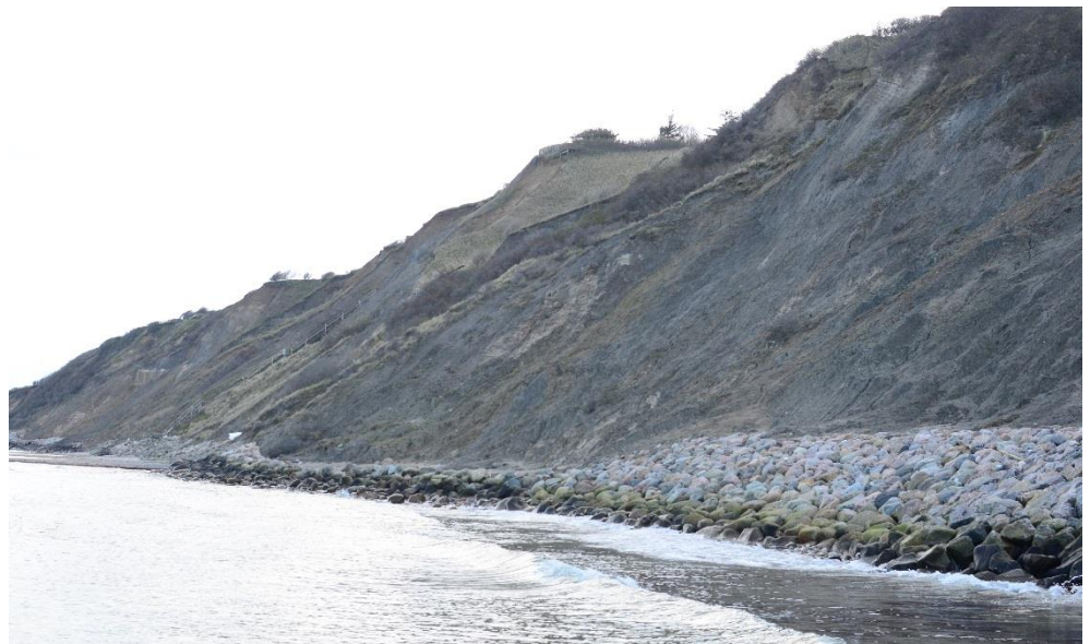
Figur 2-2 Meget stejl og høj skrånning og lav skråningsbeskyttelse ved Salgårdshøj
